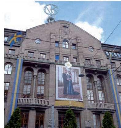
Varuhuset och gallerian NK smyckade fasaden till brudparets ära denna dag.
